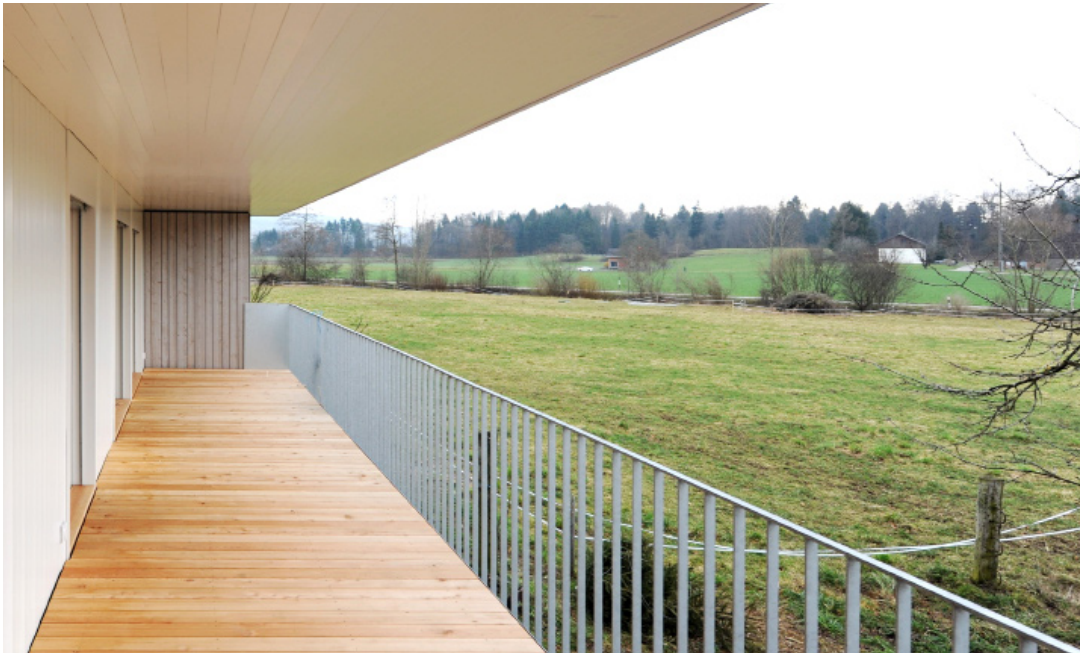
Balkonerweiterung, neue Holzfassade
